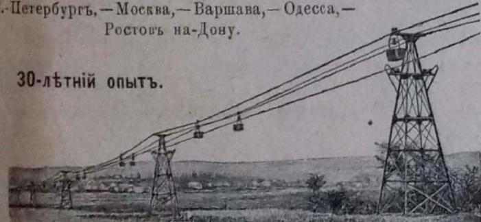
Заводомъ построено болѣе 1600 жел. дорогъ, между ними вѣсколько въ 34 километра длины, съ пролетами до 1000 метровъ и подъемами 1:1
