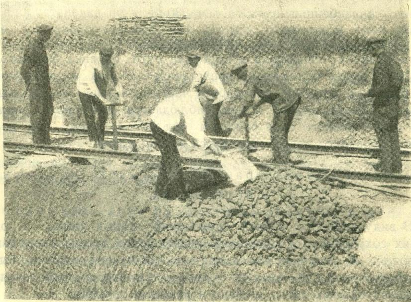
На участке, где ранее угон рельс за год достигал 225 мил.— после перехода на щебеночный стык за полтора года угон дал лишь 12 мил. Сопротивление щебня угону чрезвычайно сильно, подтверждением этому служат два случая расколотых костылями [стыковых шпал, правда не новых, но еще достаточно крепких].
